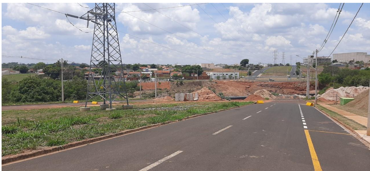
Figura 87 – Torre de transmissão de energia localizada na Av. Prefeito Mário Pozzobon
