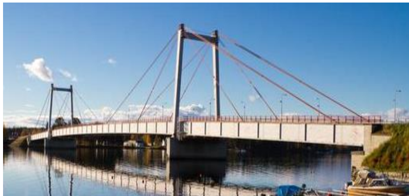
Figura 54 – Ponte Strömsund na Suécia
