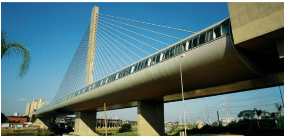
Figura 58 – Ponte Estação Metroviária Engenheiro Jamil Sabino, em São Paulo
