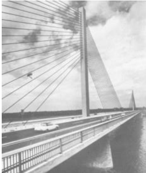
Figura 55 - Ponte Friedrich Ebert na Alemanha
