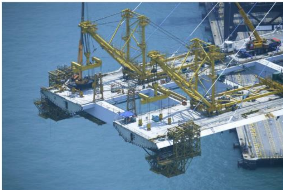
Figura 41 – Construção da ponte Stonecutters – Hong Kong
