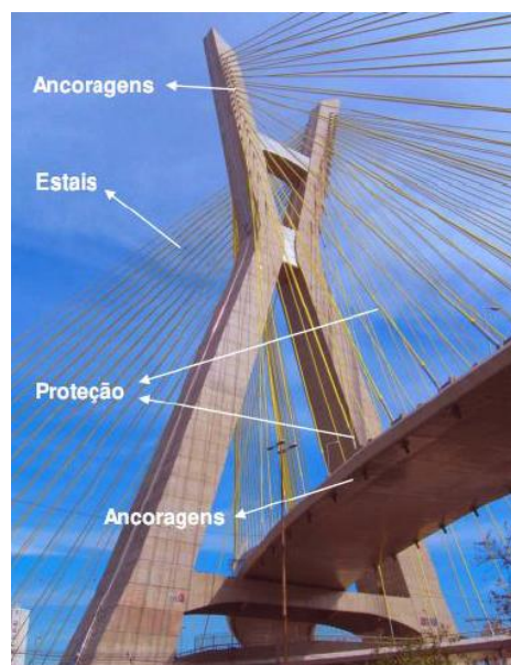
Figura 19 – Estais, suas ancoragens e proteções
