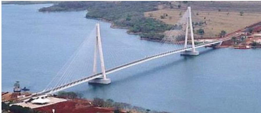
Figura 57 – Ponte sobre o rio Paranaíba entre os estados de MG e MS
