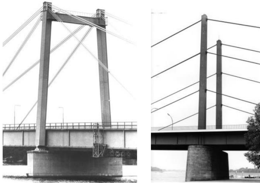
Figura 34 – Vinculações da torre com o tabuleiro
