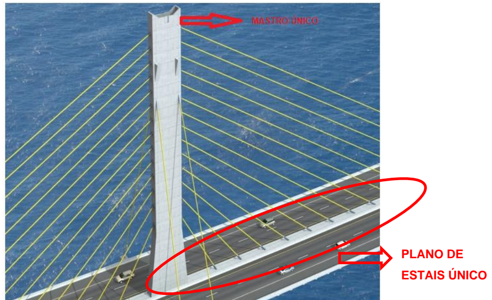
Figura 15 – Torre de mastro único com plano único de estais
